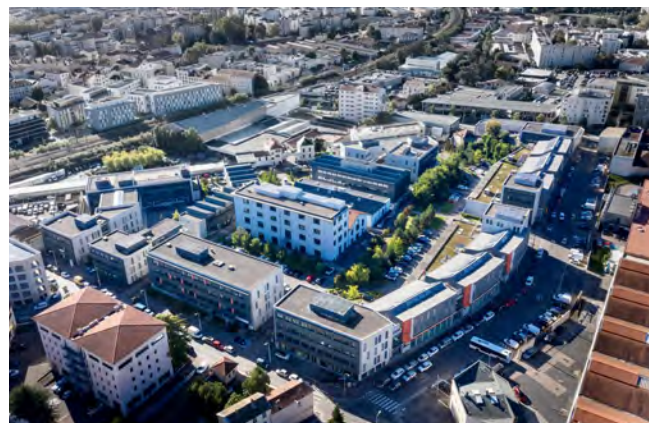
GREENOPOLIS | Rebâtir la ville sur la ville à Lyon 9 e – les 10 bâtiments de ce parc d'activité intra-muros sont chauffés et refroidis à l'aide d'une chaudière bois.
