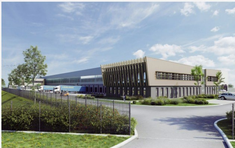
Les travaux ont débuté en décembre 2024 et devraient se terminer avant l'été 2026 — Photo : Visuel Archigroup Design
