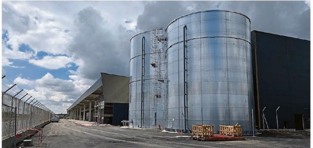
WFS investit 6 millions d'euros dans des équipements spécifiques, dont un groupe froid pour une cellule de 4.200 mètres carrés qui sera en température régulée. Photo Stéphane Frachet/Les Echos
