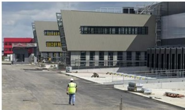
La plateforme logistique cargo-port Prologis à l'aéroport Lyon-Saint-Exupéry sera livrée cet été. Photo Le Progrès/Maxime Jegat
