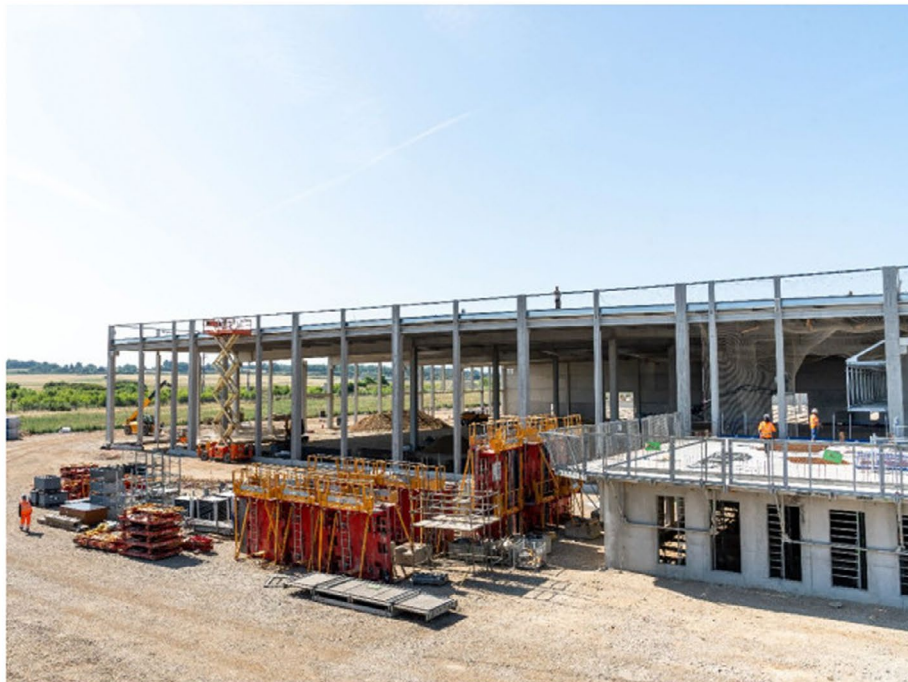
La plateforme de fret aéroportuaire Aéroport de Lyon DC1, en construction. © Nicolas Reynaud
