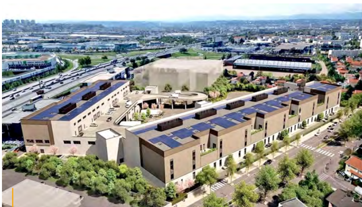
© em2c - Développé par le groupe em2c le parc d'activités Up ! proposera 26 cellules mutualisables pour un total de 21 000 m 2 de surface utile réparties sur deux bâtiments et deux niveaux.
