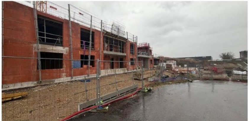
La future résidence sénior, rue Copernic à Décines-Charpieu. Photo Olivier Philippe
